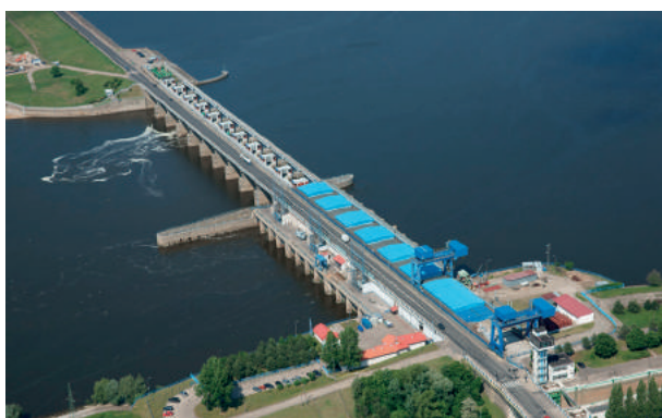
RYSUNEK 9.6. Widok jazu, elektrowni wodnej i przyczółka zapory czołowej (ziemnej) od strony wody dolnej oraz wlotu do śluzy [http://dhvhydroprojekt.com.pl/]
