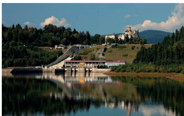
RYSUNEK 8.6. Zapora Czorsztyń-Niedzica (ziemna) na Dunajcu; przy prawym brzegu znajduje się rzelew powierzchniowy, a w części środkowej elektrownia i upusty denne [ www.niedzica.pl ]
