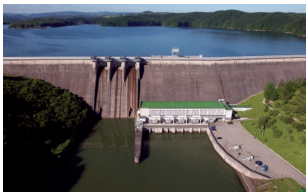
RYSUNEK 8.5. Widok zapory Solina (betonowa, ciężka) z częścią przelewową i elektrownią wodną na rzece San – widok od strony wody dolnej [ https://pgeco.pl/Nasze-obiekty/Elektrownie-wodne/Solina ]
