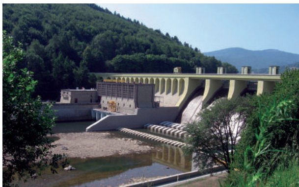
RYSUNEK 8.3. Zapora Porąbka (betonowa, ciężka) na rzece Sole – widok od strony wody dolnej [Wikipedia, ©Michał460]
