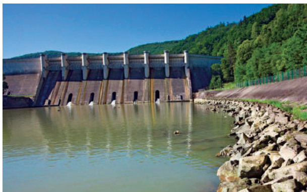
RYSUNEK 8.4. Widok od strony wody dolnej części przelewowej z upustami dennymi zapory Rożnowskiej na Dunajcu [http://www.tauron-ekoenergia.pl/elektrownie/energia-wodna/zew-krakow/]
