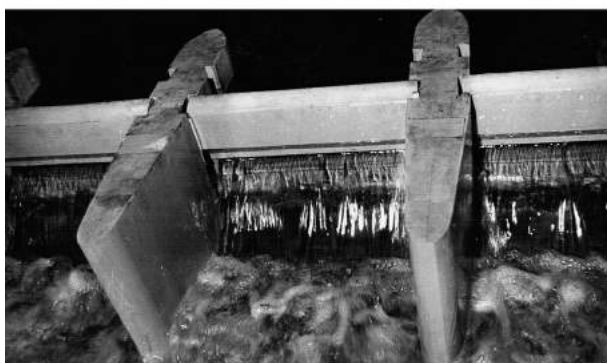
Przepływ przez jaz przy częściowo podniesionych zasuwach (widok od strony wody dolnej)
