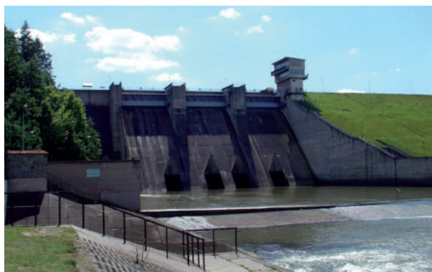
RYSUNEK 8.7. Zapora Dobczyce (ziemna) na rzece Rabe; widok części przelewową od strony wody dolnej [ https://www.dobczyce.pl/dla-turystow/ ]
