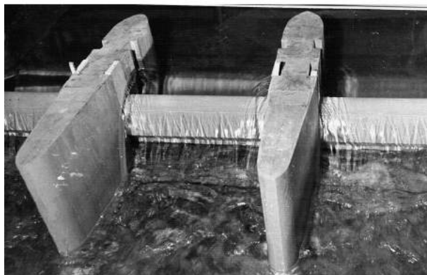
Przepływ przez jaz przy opuszczonych zasuwach widok od strony wody dolnej
