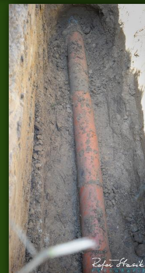
Instalacja opracowanego w ramach projektu INOMEL prototypu studzienki piętrzącej dziale drenarskim 42.2 (ze wstrzymywaniem odpływu) 29 maja 2019
