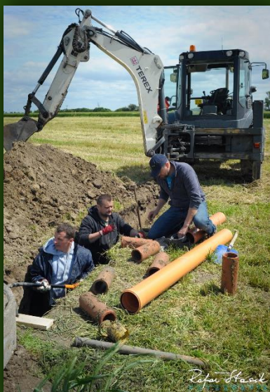
Instalacja opracowanego w ramach projektu INOMEL prototypu studzienki piętrzącej dziale drenarskim 42.2 (ze wstrzymywaniem odpływu) 29 maja 2019
