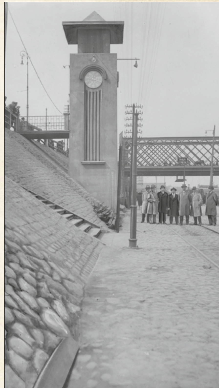
Samoczynny wodowskaz elektryczny w pobliżu Mostu Kierbedzia; 1932
