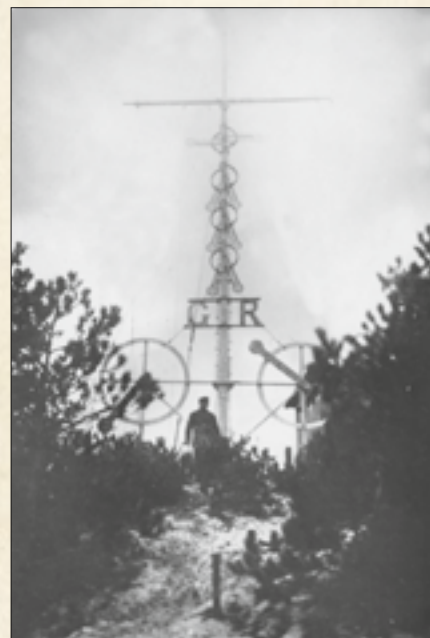
Maszt sygnałowy na Helu; lata 30.
