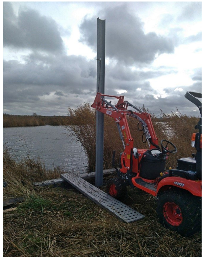
Budowa stacji wodowskazowej Łebsko na rzece Łebie.
