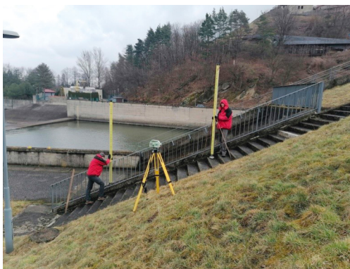
Pomiary przemieszczeń pionowych zapory Dobczyce (fot. archiwum CTKZ).
