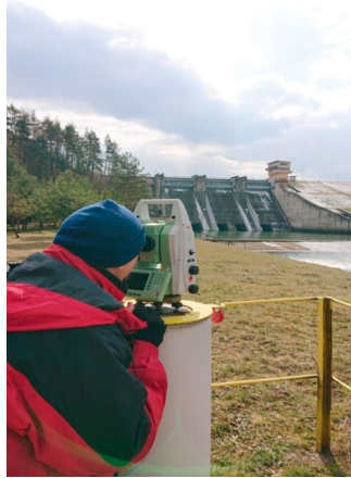
Pomiary przemieszczeń poziomych zapory Dobczyce (fot. archiwum CTKZ).
