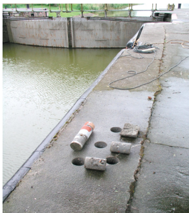
Odwiercone rdzenie na śluzie Nakło Wschodnie (fot. archiwum CTKZ).
