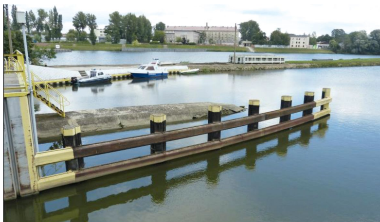
Rys. 2. Dalby naprowadzające.
