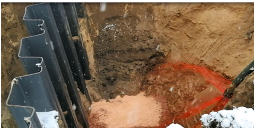
Rys. 7. Wypełnianie wykopu wodą z barwnikiem.
