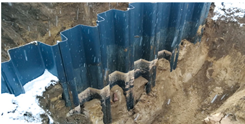
Rys. 6. Zdjęcie grodziec po odkopaniu części ściany z obu stron.
