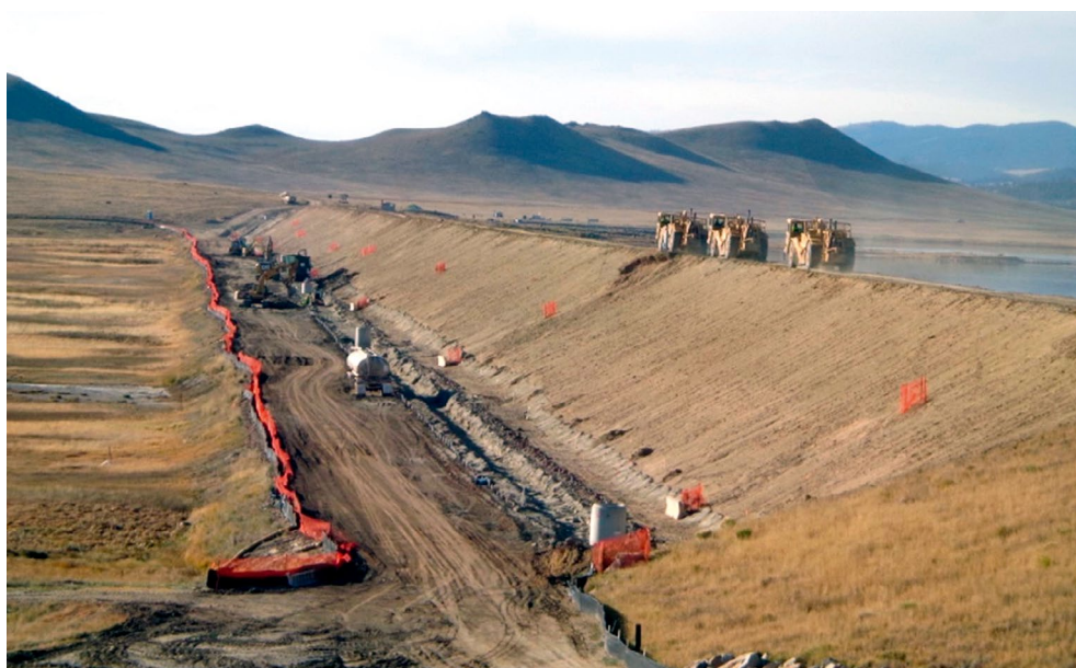
Rys. 1. Widok na skarpe odpowietrzną w trakcie modernizacji obiektu [źródło: https://www.rjh-consultants.com/ ].
