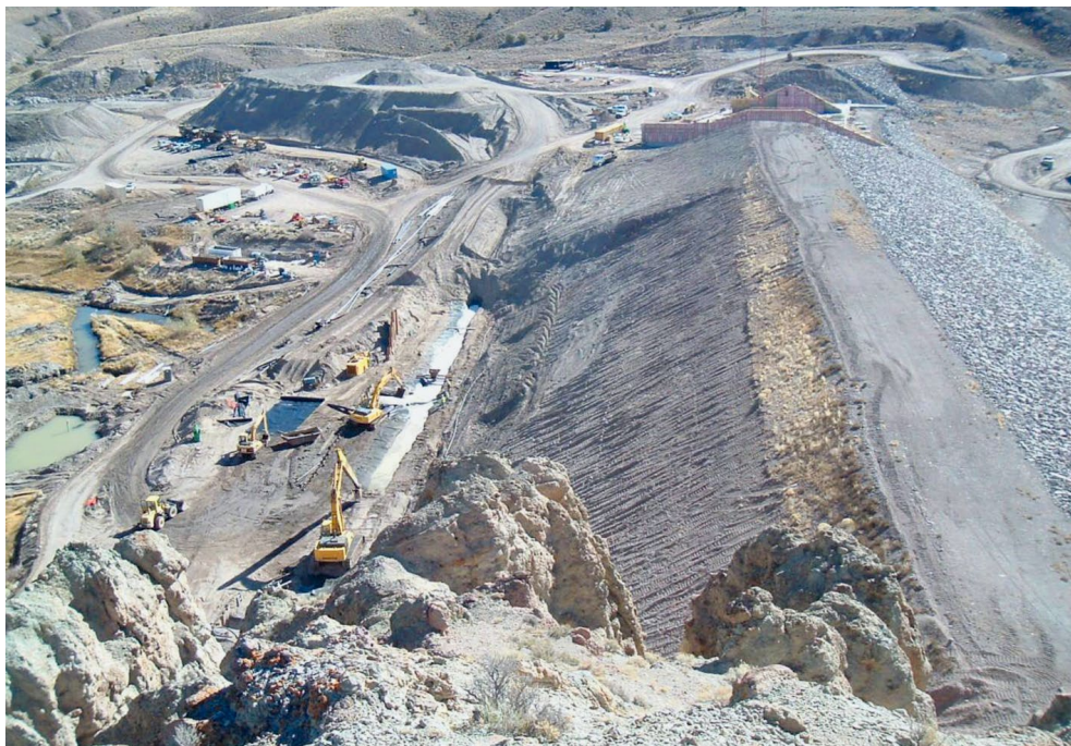
Rys. 3. Głębienie przesłony z wykorzystaniem zawiesziny biopolimerowej [źródło: https://fransoncivil.com/ ].
