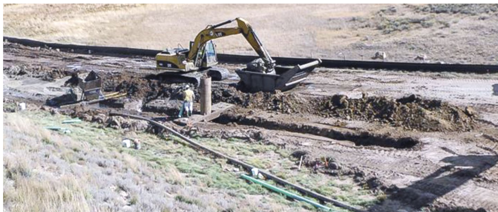
Rys. 2. Zrzut kruszywa do szczeliny wypełnionej polimerem przy pomocy rury kontraktorowej
