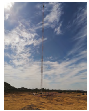
Saudi Arabia Installed 100 meter MET MASTS
