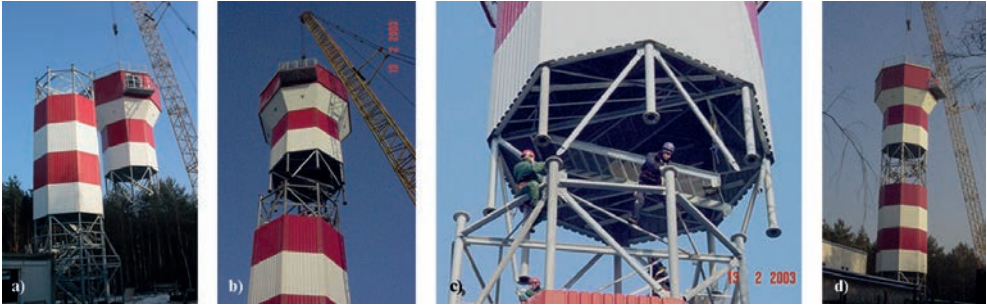
Rys. 9.12. Montaż wieży radarowej: a) początek operacji podnoszenia części górnej wieży, b) i c) moment przed ustawieniem części górnej na części dolne, d) zakończenie ustawienia, fot. Raport z postępy prac Nr 7, SMOK
