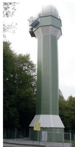
Rys. 9.24. Stacja radarowa w Brzuchani
