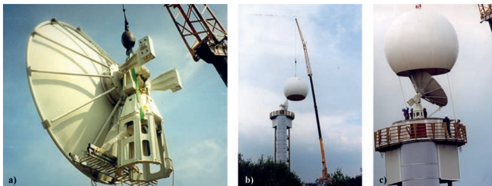
Rys. 7.9. Montaż anteny radarowej i jej osłony na stacji Pastewnik, fot. Ryszard Klejnowski
