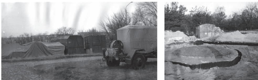
Rys. 5.1. Budowa radaru MRŁ-5: a) radar MRŁ-5 oczekuje na zainstalowanie, b) fundamenty pod wieżę radarową
