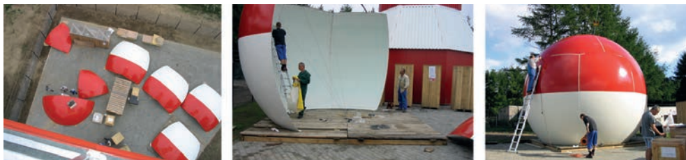
Rys. 9.16 . Montaż kopuły osłaniającej antenę radaru – stacja Świdwin
