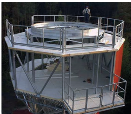
Rys. 9.15. Zwieńczenie części górnej wieży, na której zainstalowane będą urządzenia radarowe: radar i antena osłonięta kopułą.
