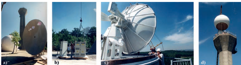
Rys. 7.3. Budowa stacji radarowej na wzgórzu Ramża – 21 lipca 1995 r.: a) wieża przygotowana do zamontowania urządzeń radarowych, b) montaż elementów radaru, c) montaż anteny, d) montaż kopuły radarowej, fot. Ryszard Klejnowski
