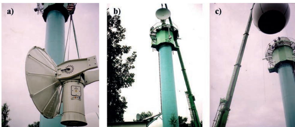
Rys. 9.5. Montaż elementów anteny nowego radaru na wieży w Legionowie
