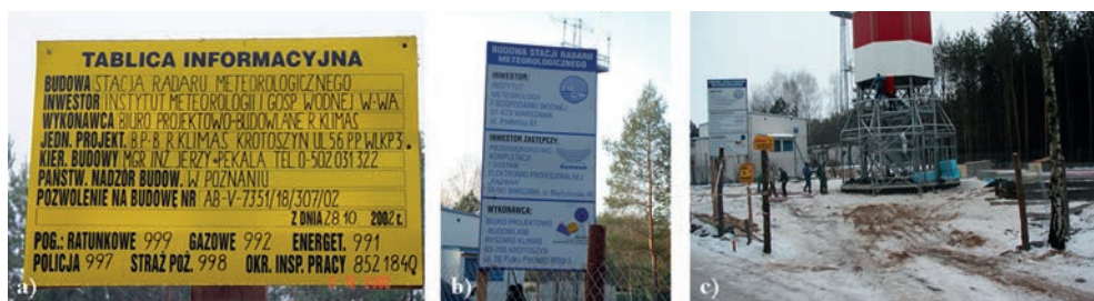
Rys. 9.11. Rozpoczęcie budowy radaru w Poznaniu: a) i b) tablice informacyjne na obiekcie: inwestor i główni wykonawcy, c) plac budowy – widok dolnej konstrukcji wieży, fot. Raport z postępu prac Nr 4, SMOK
