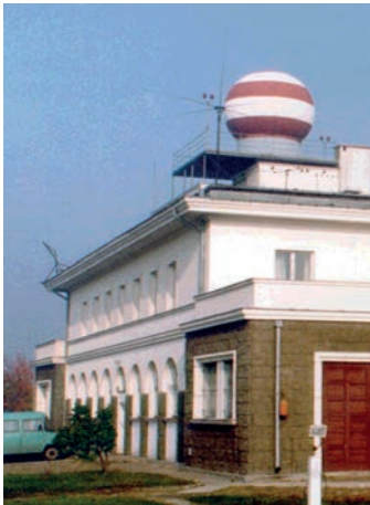
Rys. 3.19. Odnowiona kopuła anteny radaru MRL-2 (istotne z powodu tłumienia sygnału radarowego przez kopułę) na budynku Zakładu Aerologii
