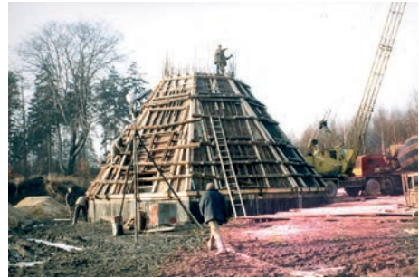
Rys. 7.1. Rozpoczęcie budowy wieży radarowej na wzgórzu Ramża – rok 1994, fot. Ryszard Klejnowski
