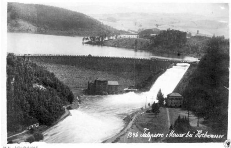
BOBERTALSPERRE PILCHOWICE (MAUER), STAND 1946
