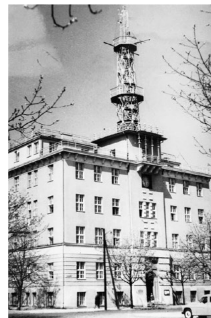
Budynek Oddziału Morskiego PIHM przy ul. Waszyngtona 42 w Gdyni w latach 60. XX w., z widocznym na dachu masztem służącym do umieszczania ostrzeżeń sztormowych (archiwum IMGW).
