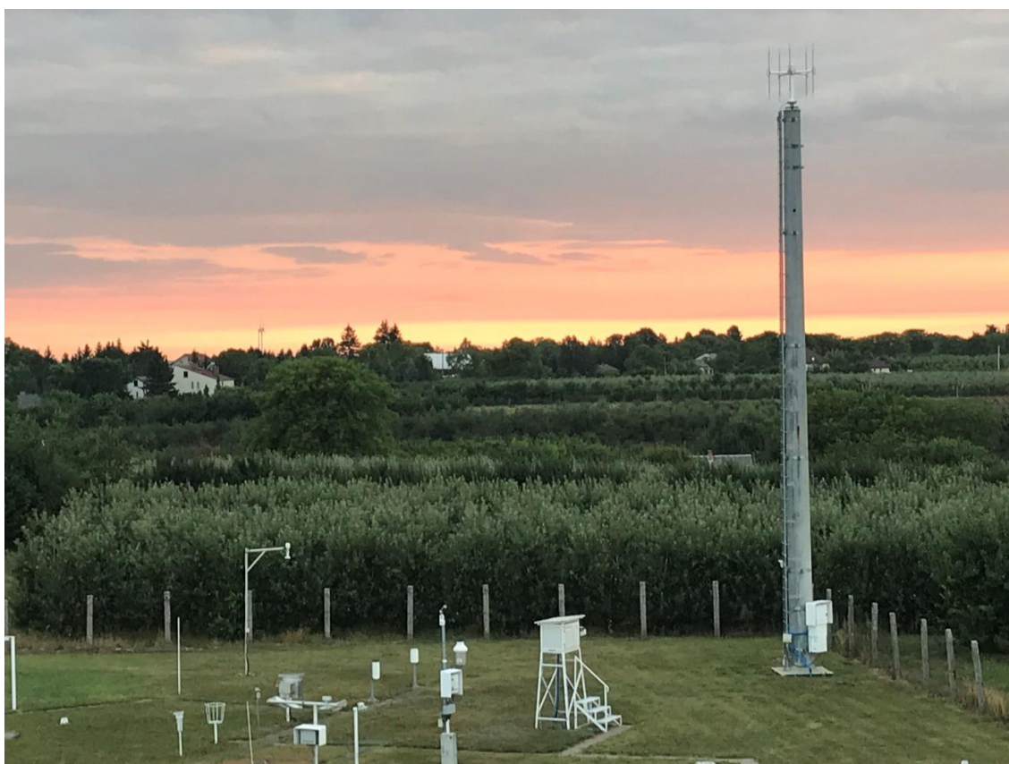
Maszt i czujnik systemu PERUN na stacji meteorologicznej w Sandomierzu.
